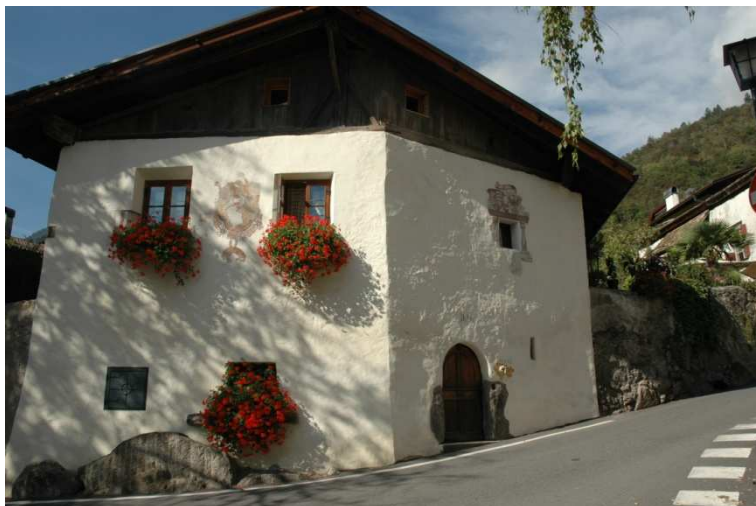
Abb. 14 Gebäude bei der Stachelburg
